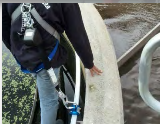
Detalle del carro sobre el riel.
